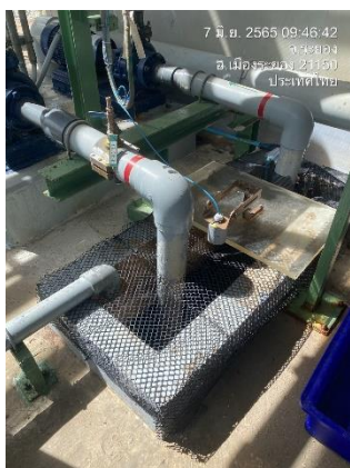
ภาพที่ 2-10 ถังปรับสภาพ (Neutralization Basin) (ไต้ดิน)
